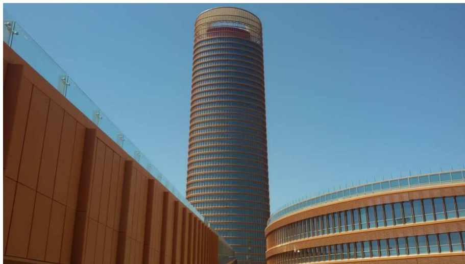
Torre Pelli, Hiszpania, zabezpieczenia przeciwpożarowe
