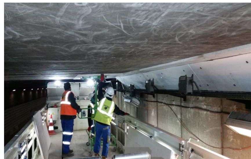
Tunel Sevigne, Paryż, Francja, zabezpieczenia przeciwpożarowe
