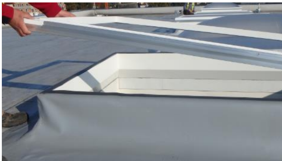
Rys. 10. Układanie wieńca PVC na uszczelce PES.
