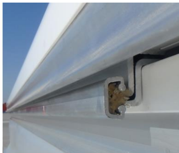
Rys. 21. Zawias z zamontowanym łącznikiem.
