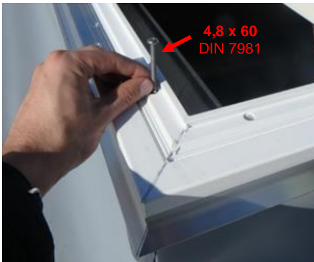
Rys. 35. Przykręcanie wieńca PCA do podstawy metalowej.
