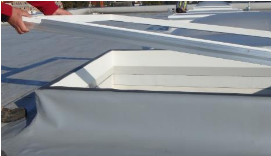
Rys. 34. Układanie wieńca PVC na uszczelce PES.
