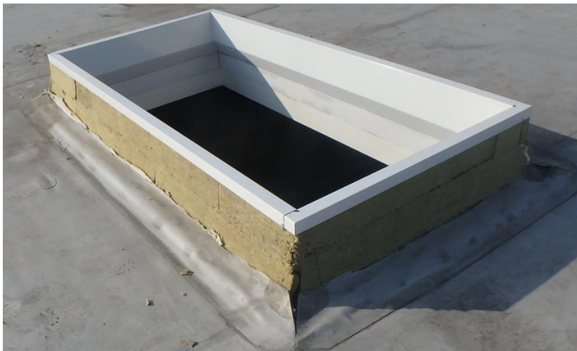
Rys. 31. Ocieplona podstawa (grubość izolacji wynosi 50 mm).
