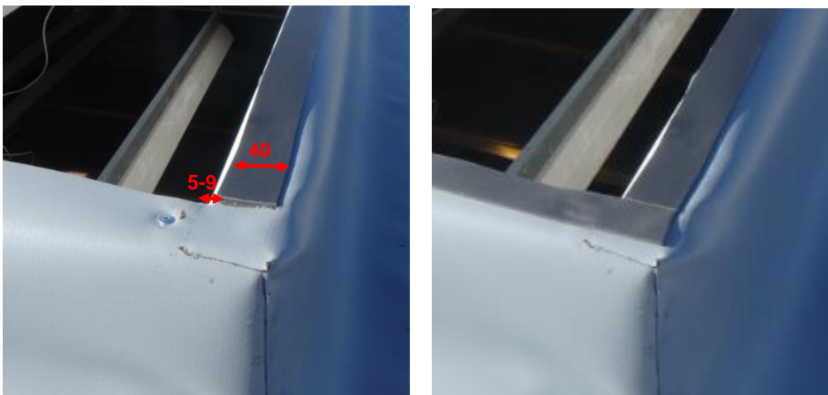
Rys. 33. Przyklejona uszczelka PES 40x3. Zwrócić uwagę na doczołowy styk uszczelki w narożniku.
