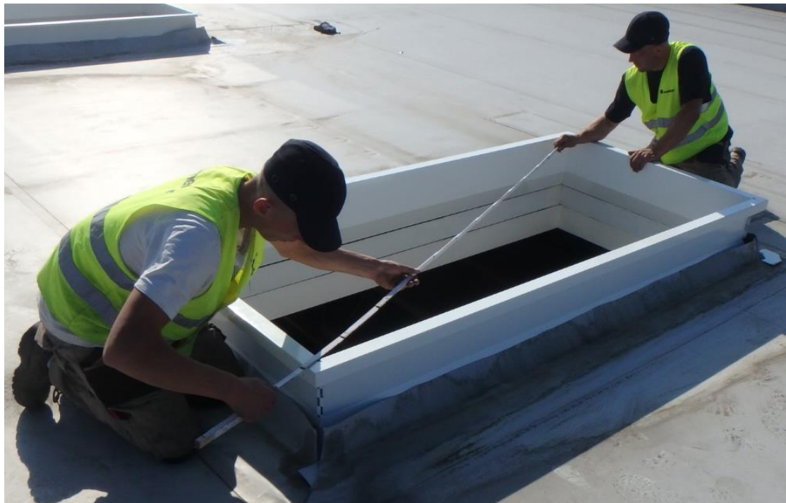
Rys. 29. Sprawdzanie przekątnych.
