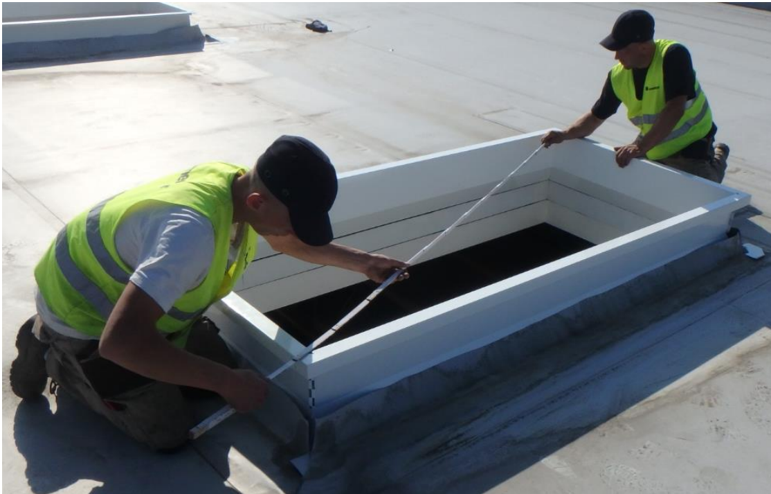
Rys. 29. Sprawdzanie przekątnych.
