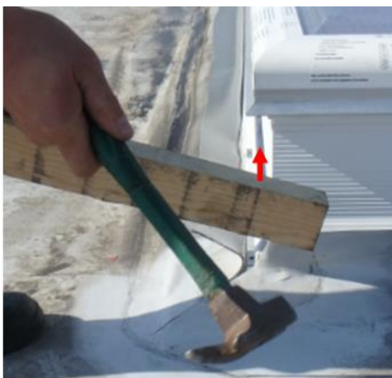
Rys. 42. Nabijanie łącznika.
