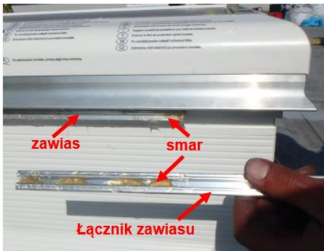
Rys. 40. Smarowanie zawiasu.
