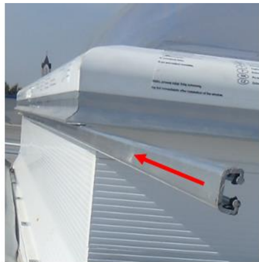
Rys. 41. Nasuwanie łącznika.
