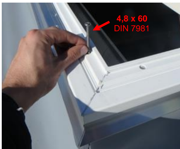
Rys. 35. Przykręcanie wieńca PCA do podstawy metalowej.
