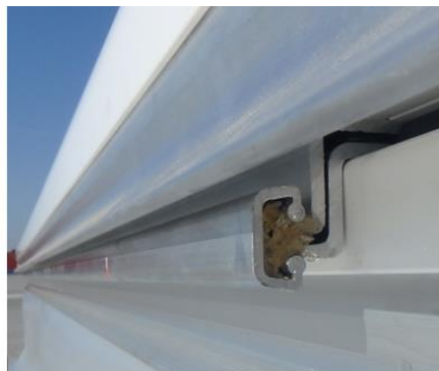
Rys. 43. Zawias z zamontowanym łącznikiem.
