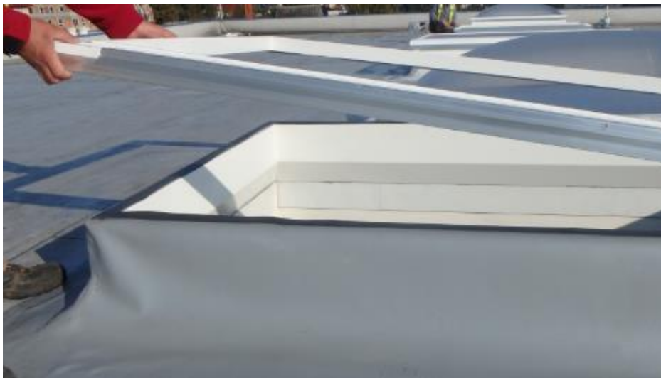
Rys. 34. Układanie wieńca PVC na uszczelce PES.
