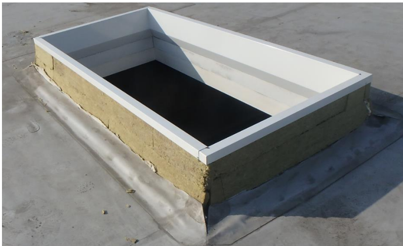
Rys. 31. Ocieplona podstawa (grubość izolacji wynosi 50 mm).
