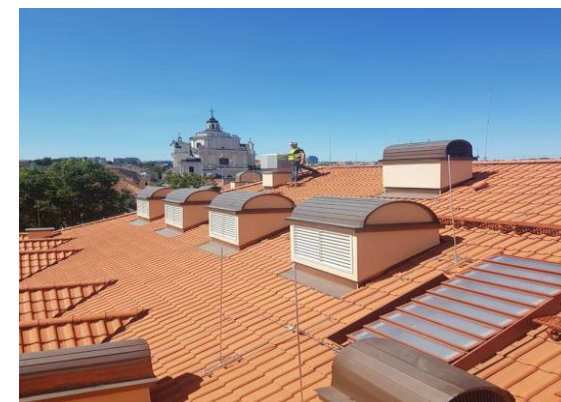
Ambasada RP w Wilnie, systemy wentylacji pożarowej
