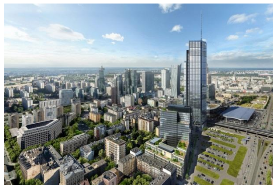
Varso Tower, systemy wentylacji pożarowej
