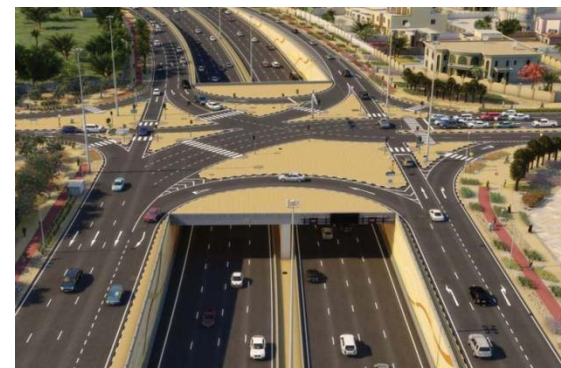
Al Rayyan Road Tunnel, Katar, Doha, ogniochronne zabezpieczenia konstrukcji
