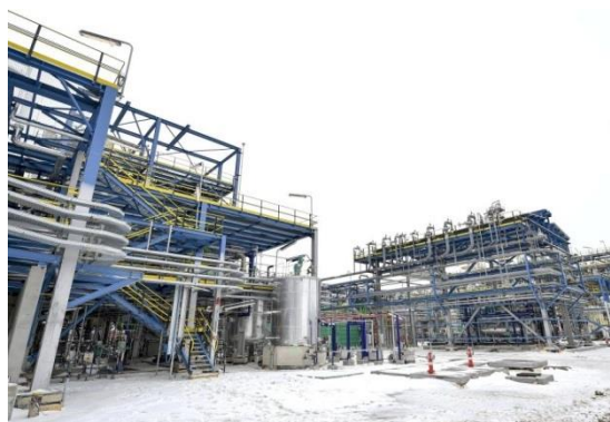
Fabryka kauczuku Grupy MOL, Węgry, ogniochronne zabezpieczenia konstrukcji
