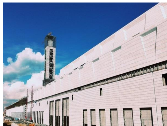
Great Mosque, Algieria, ogniochronne zabezpieczenia konstrukcji
