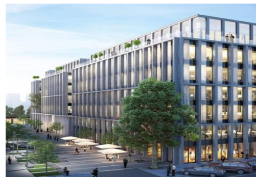
Biurowiec Nowogrodzka Square, Warszawa, systemy wentylacji pożarowej
