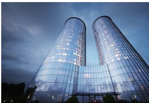
Z-Tower Riga, Łotwa, ogniochronne zabezpieczenia konstrukcji
