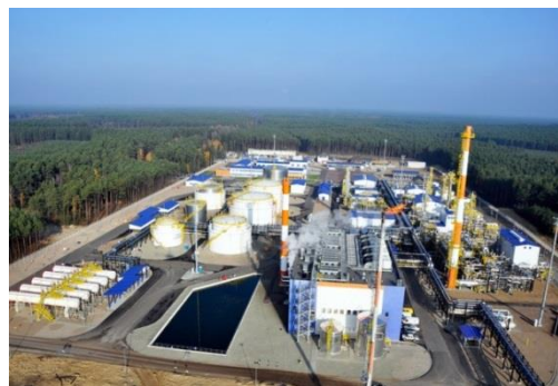
Kopalnia Gazu Ziemnego LMG dla PGNiG, ogniochronne zabezpieczenia konstrukcji
